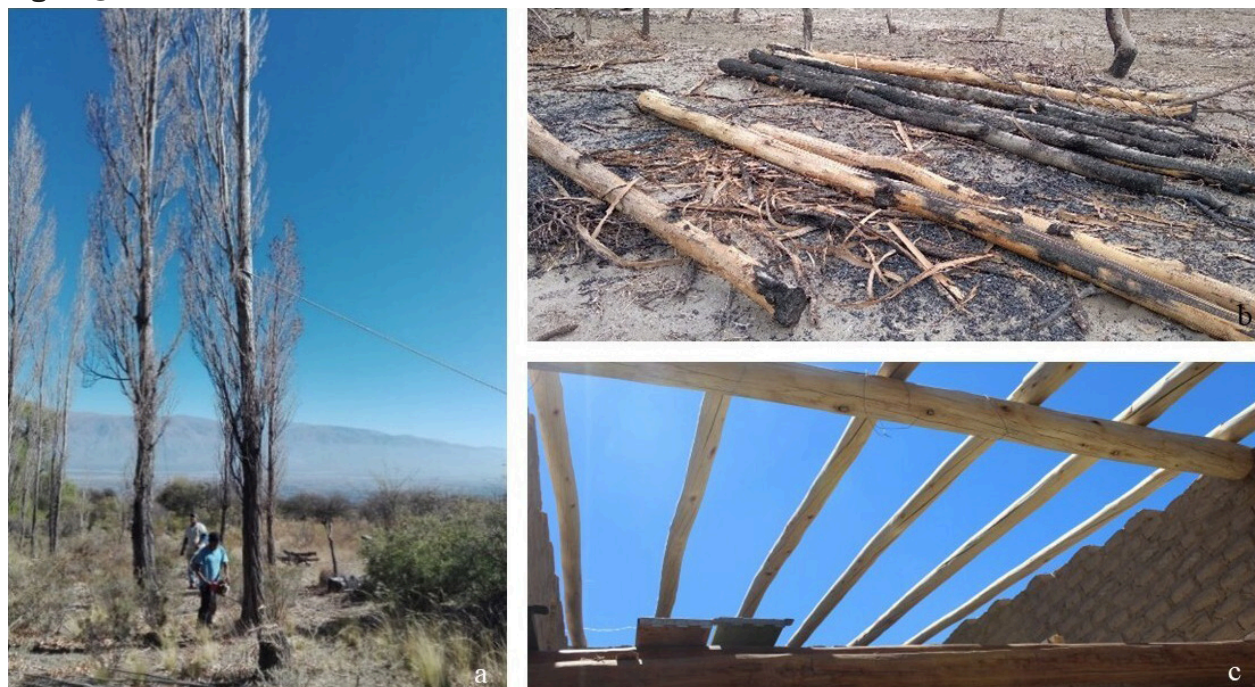
Figura 3.- Transformación de un árbol a elemento constructivo
