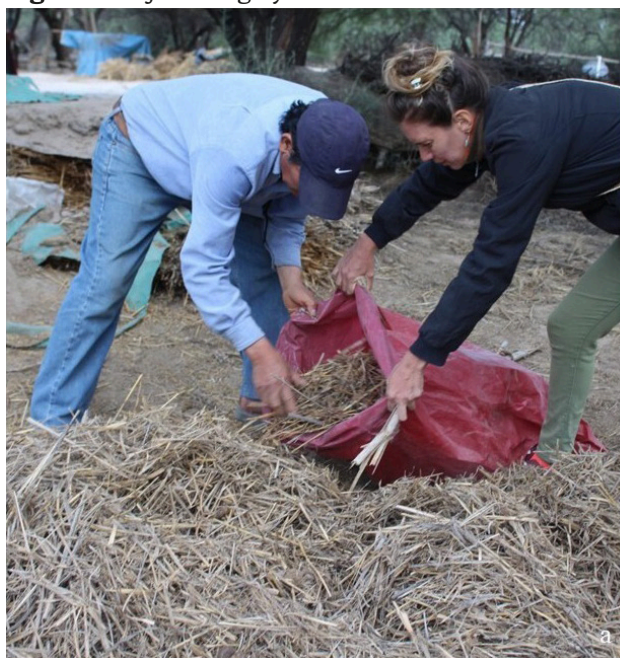
Figura 2. Paja de trigo y elaboración de adobes
